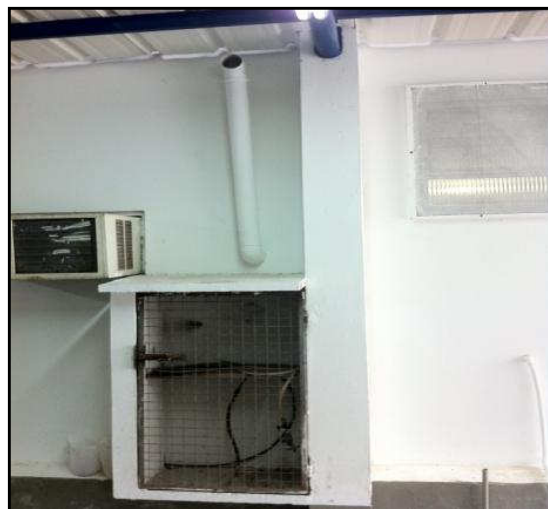
Exaustão de capela situada sob telhado
